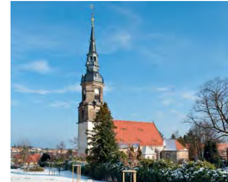
Possendorf, Ev. Kirche
