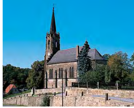
Berggießhübel, Ev. Kirche
